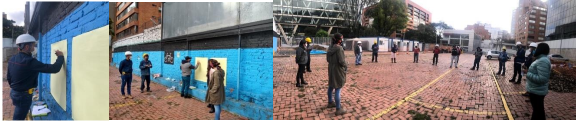
Jornada de capacitación equipo de obra
