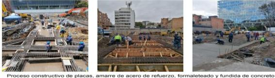
Proceso constructivo de placas, amarre de acero de refuerzo, formateado y fundida de concreto
