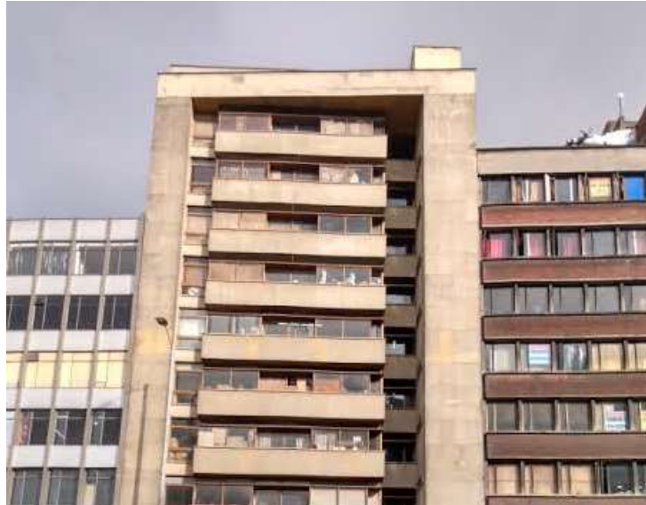
Fachada principal. Fuente: Niño y Reina, La Carrera de La Modernidad, 2014
