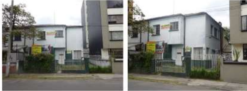
Fachada principal. Fuente: visita técnica, Agosto 2020.
