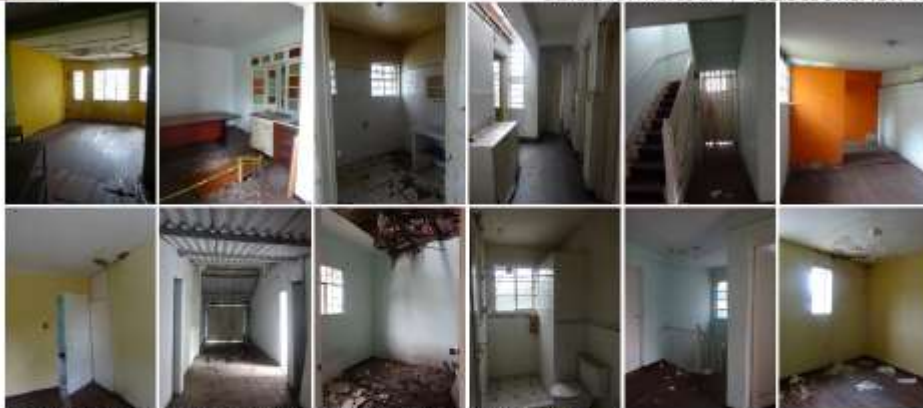
Espacios interiores -áreas sociales y privadas. Fuente: visita técnica, Agosto 2020.
