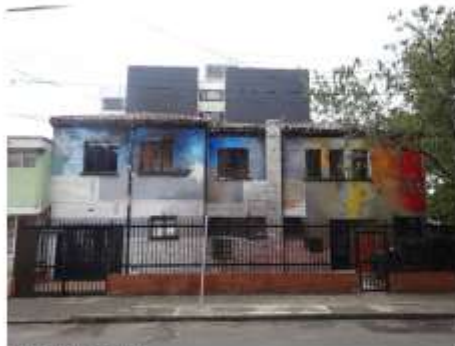
Fachada principal. Fuente: visita técnica, Agosto 2020.
