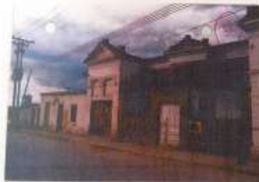
FACHADA EXISTENTE AÑO 1998
