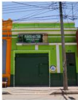
ALTERACIÓN DE FACHADA 2021
