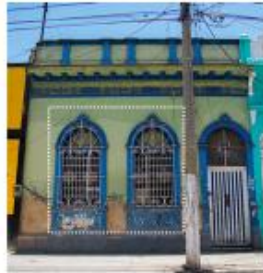
ALTERACIÓN DE FACHADA 2021
