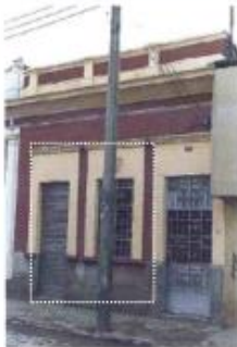
ALTERACIÓN DE FACHADA 2001
