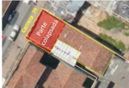
Volumen colapsado por las lluvias en noviembre de 2020. Fuente: Mapas Bogotá, 2021. / Archivo fotográfico Parroquia de las Cruces.
