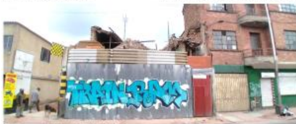
Estado actual de la fachada 2021. Fuente: Fuente: Visita IDPC mayo 2021.
