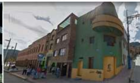
1951. Vista de las fachadas, actualizada en 2019. Fundación Guzmán, 2014, 2019.
