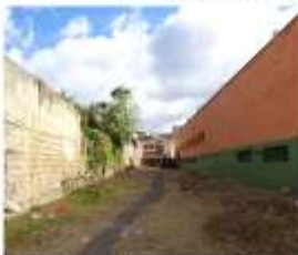
vista inferior hacia el sur.
