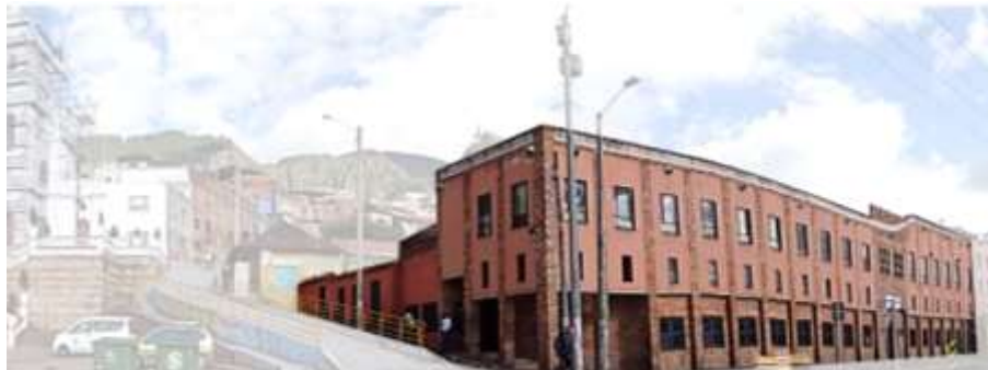
Imagen 4. Inmueble objeto de la solicitud. Fuente: Visita técnica IDPC, 2019.
