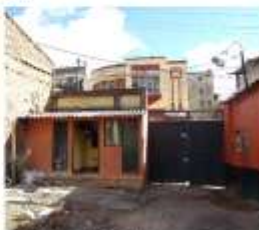
vista inferior hacia el sur.
