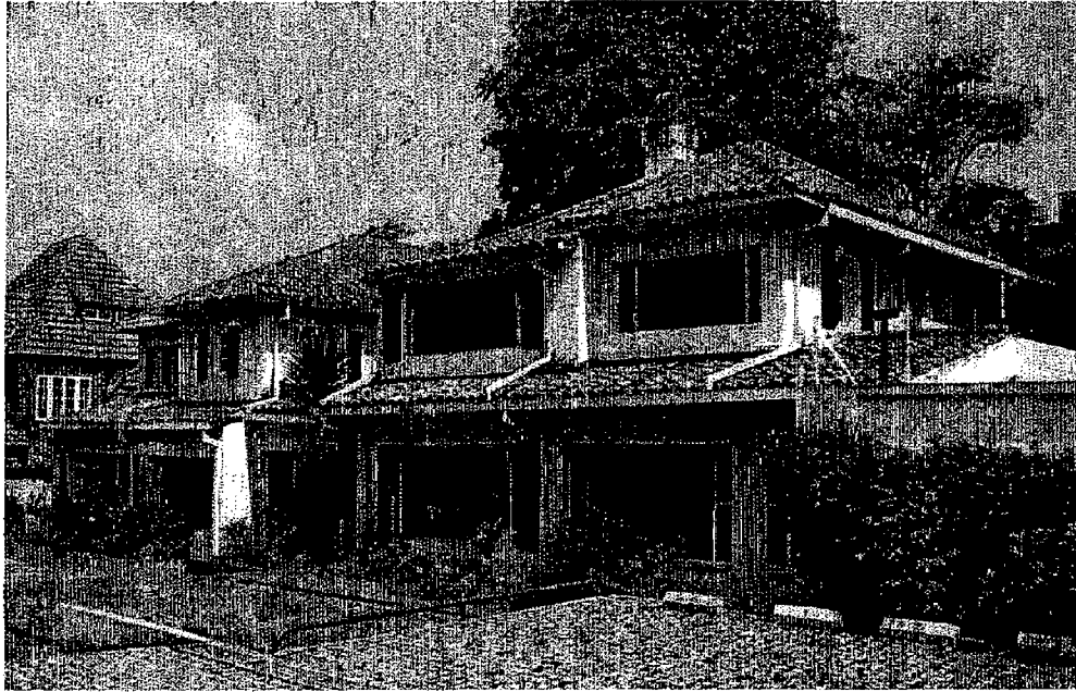
Imagen 6. Fachada predio Calle 75 # 11-60 / 62
