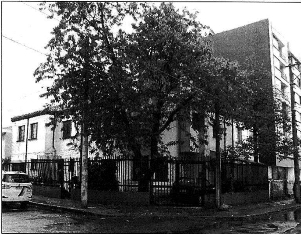
Imagen 18. Carrera 18 A No. 53-87 / Calle 53 B No. 18 A-17, fuente: IDPC, 2016.
