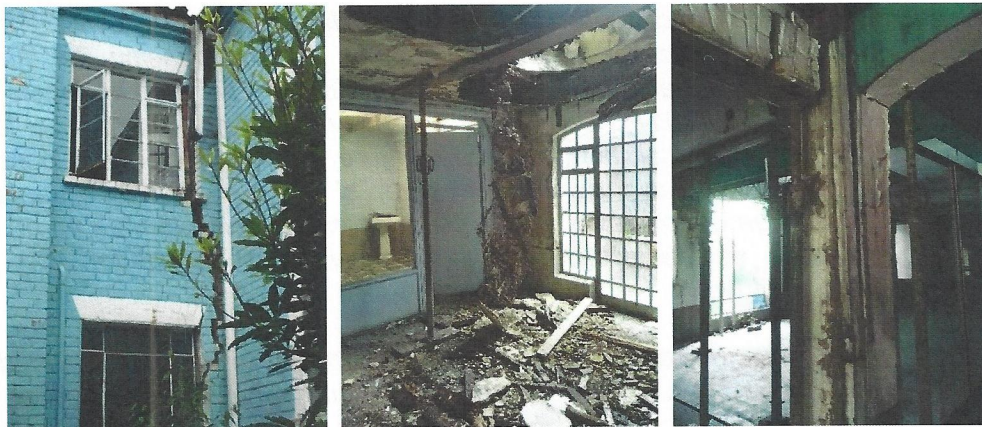
Imagen 7: Estado actual del inmueble. Fuente: Fotografías IDPC, 2017.
