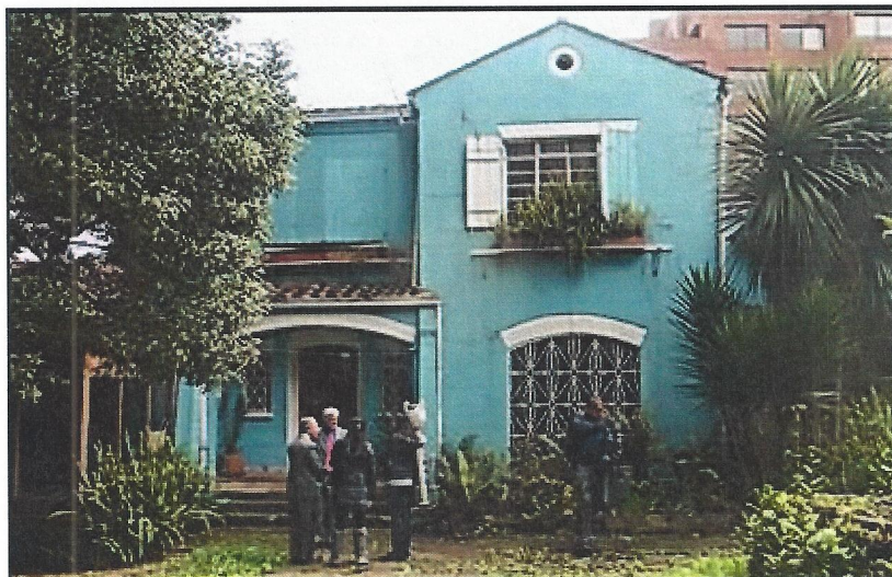
Imagen 6: Fachada principal. Fuente: Fotografía del solicitante, 2017
