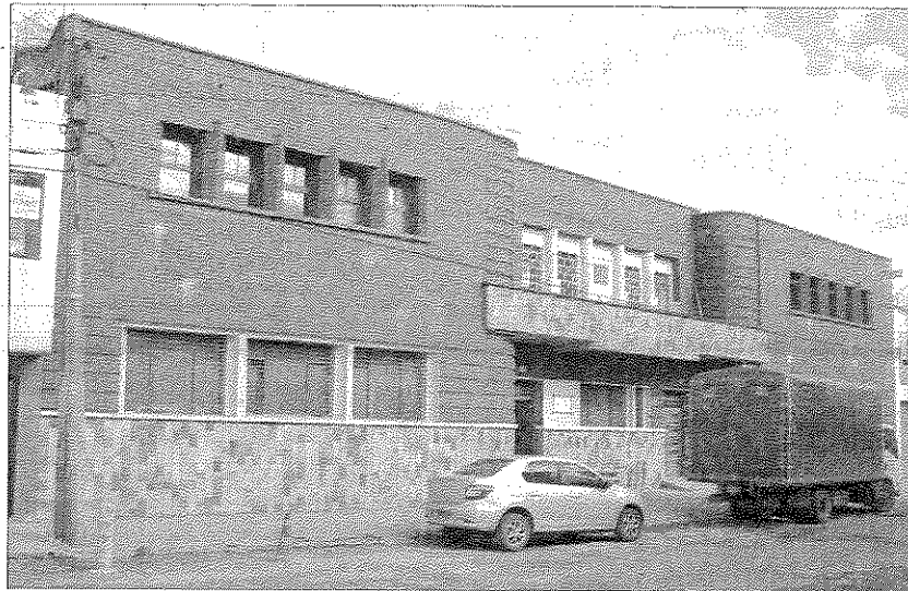
Imagen 12: Fachada principal. Fuente: Fotografía IDPC, 2017
