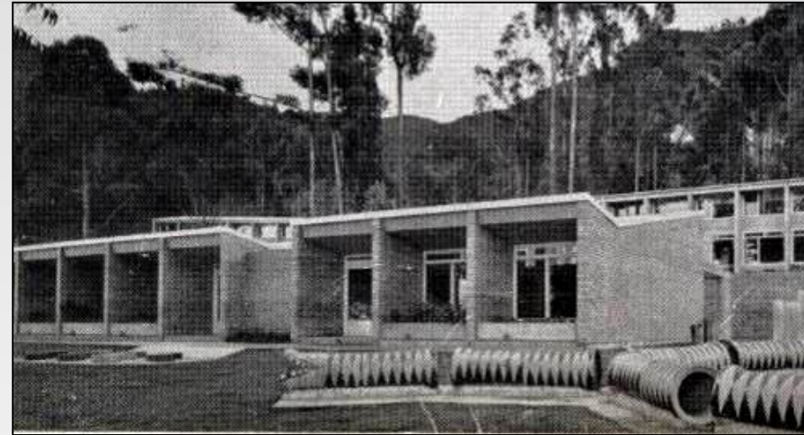
Edificio K&N / Bloque P - 1960
