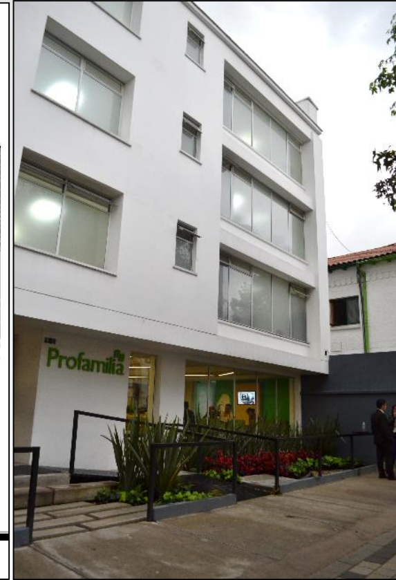
Imagen exterior. Fuente: IDPC, 2016.
